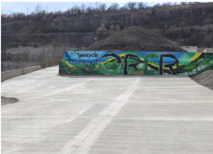
Abbildung 4: Betonoberflächen nach dem Schneiden der Fugen
