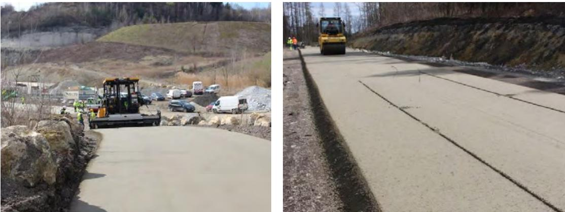
Abbildung 1: links: Betoneinbau mit Volvo Kettenfertiger; rechts: Nachverdichtung mit Glattmantelwalze
