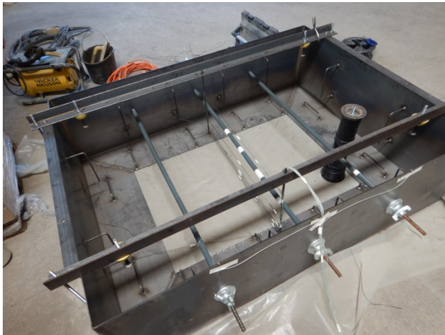
Abb. 2: Zur Betonage vorbereitete Schalung der Großkörper
