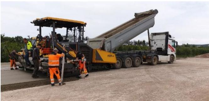
Abbildung 2: Herstellung von Walzbeton auf einer Industriefläche
