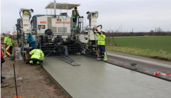
Abbildung 1: Einbau von White Topping mit Betondeckenfertiger
