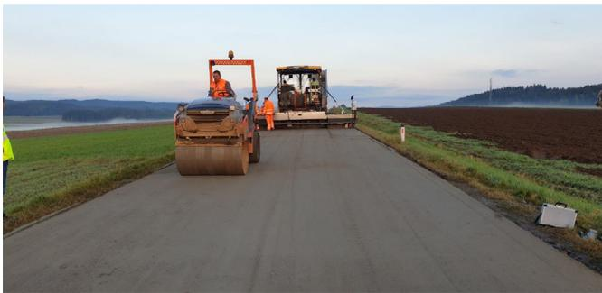
Abbildung 2: Herstellung von Walzbeton auf einem Straßenabschnitt
