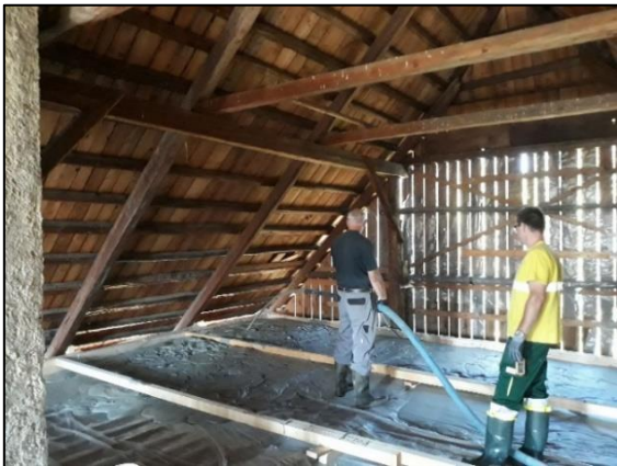
Abbildung 4 Dämmung eines 300 J. alten Bauernhauses
